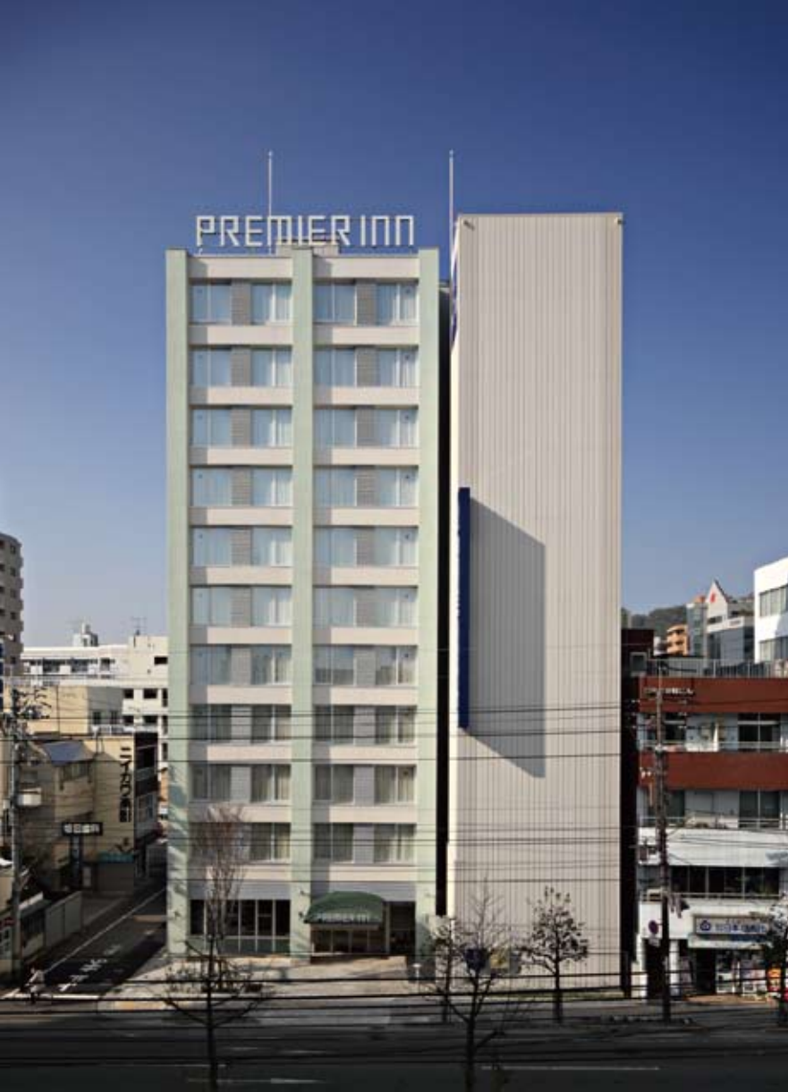
プレミアイン松山／国道側全景。右手の無窓部分はタワーパーキング。
