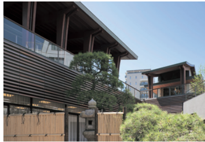
(写真4) 山門より本堂と観音堂を見る
